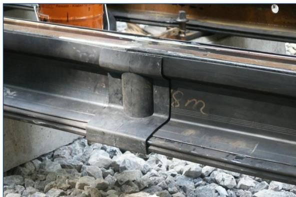
**Abb.23.1.7 Fachgerechte Abdichtung des Schweißstoßes** (Quelle: Datwyler Sealing Technologies)
