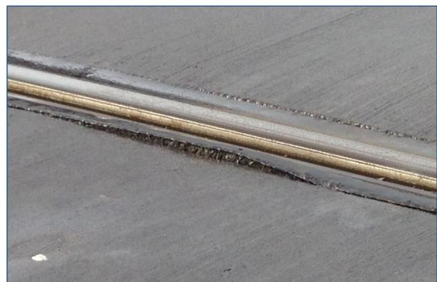
Abb.27.1.3 Fugenverguss von Betondecke abgerissen, da Verbund zum Kammerfüllelement vorhanden (kein Trennstreifen)
