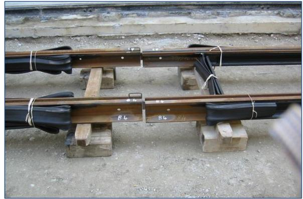
**Abb.23.1.2 korrekte Montage im Bereich einer geplanten Schweißung** (Quelle: Datwyler Sealing Technologies)
