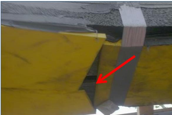
Abb.17.1 Fehlerhafte Isolation der Herzstückunterseite (Arbeiten im Weichenwerk ausgeführt)
