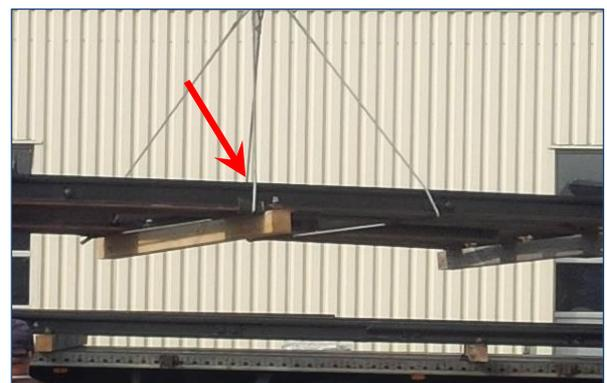
**Abb.18.3.7 Heben mit Stahlseilen, Schienenunterkante wurde durch Unterlage geschützt**
