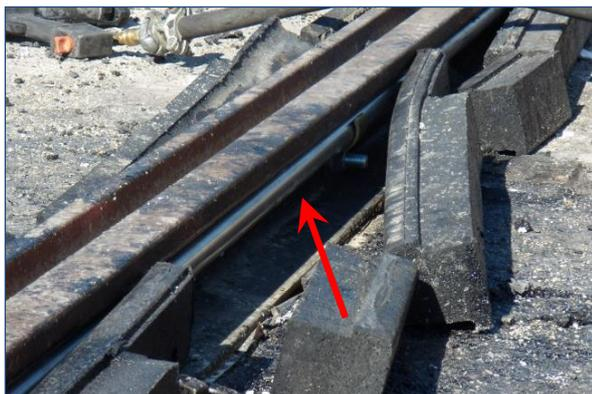
**Abb.23.1.5 Planungsfehler – wie sollen im Bereich des Leerrohres die Kammerfüllelemente passen?**
