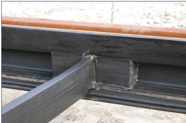
**Abb.23.1.3 korrekte Isolierung des Spurstangenprofils** (Quelle: Datwyler Sealing Technologies)
