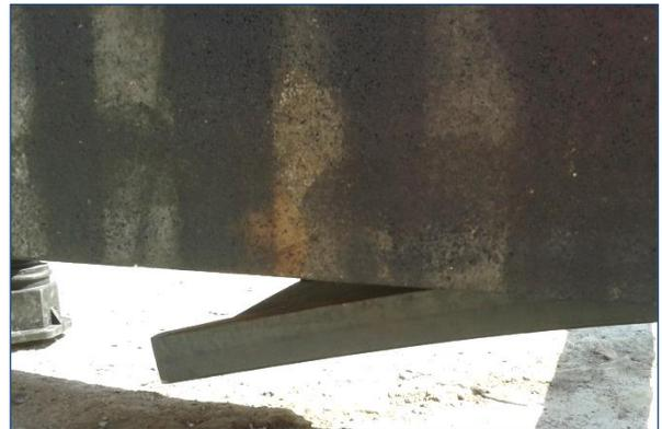
**Abb.23.1.4 nicht korrekt befestigtes Fußprofil**
