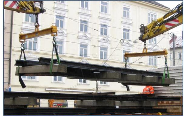
**Abb.18.3.3 Heben mit 2 Quertraversen und ZW**
