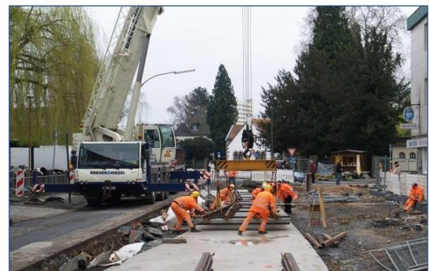
**Abb.18.3.9 Heben mittels Quertraverse und Autokran (möglich, da keine Fahrleitung vorhanden)**
