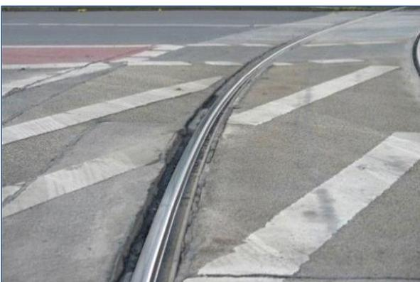
Abb.27.1.2 „Nicht standfeste“ Kammerfüllung bzw. fehlerhafter Untergruss bewirkt ein Absacken der Schienenfuge
