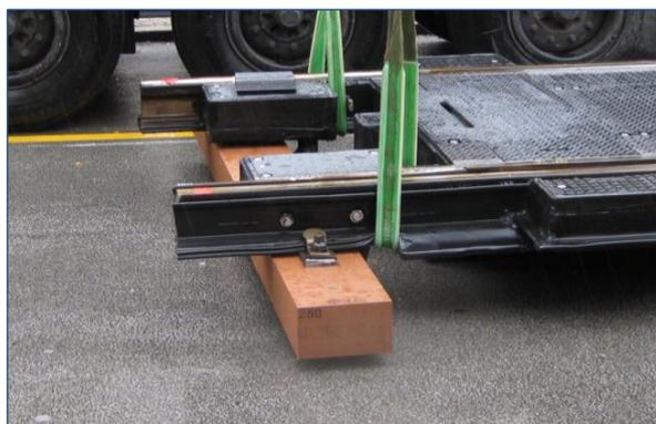
**Abb.18.3.6 Heben mit Nylon Schlüpfen (Fußprofil der Isolierung sollte durch Zwischenlage geschützt werden, besser Anschlag an Schwelle und gegen Abrutschen (nasse Kunststoffschwelle) gesichert)**
