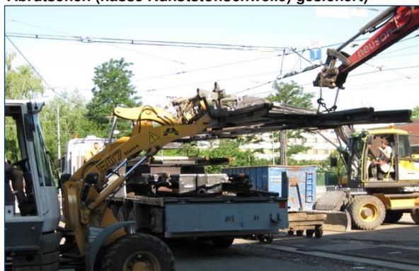
**Abb.18.3.8 Sehr problematisch: Entladung mit zwei Zweiwegebagger (Weiche direkt an Kette angeschlagen) und Radlader unter Fahrleitung**
