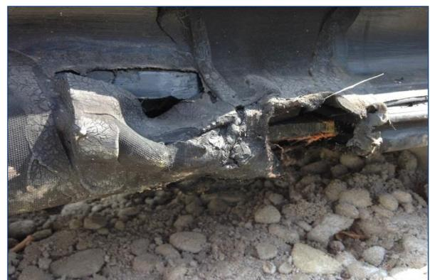
**Abb.23.1.6 durch Einsatz einer Kette beschädigte Fußisolierung (Weiche wurde so einbetoniert)**
