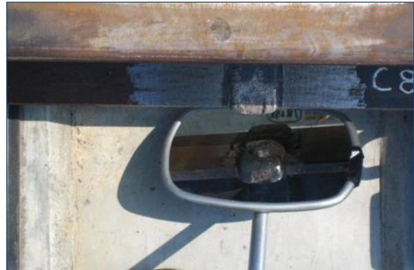
Abb.17.2 Mangel wäre durch Einsatz eines Inspektionsspiegels detektiert worden
